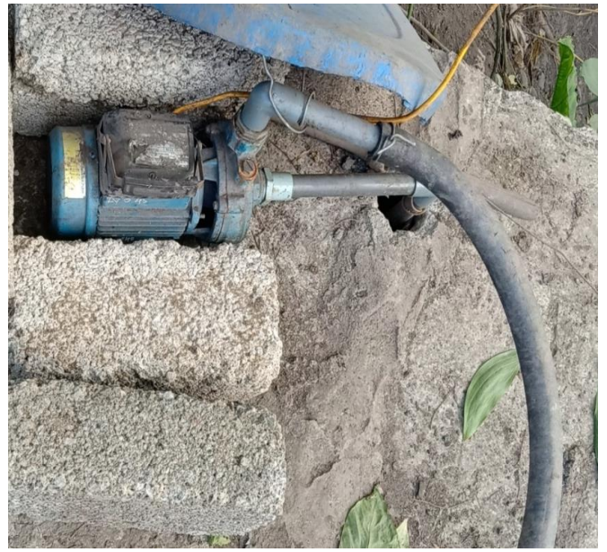
Hình 3.5. Bơm nước thải sau bể tự hoại lên bề mặt lắng thô
