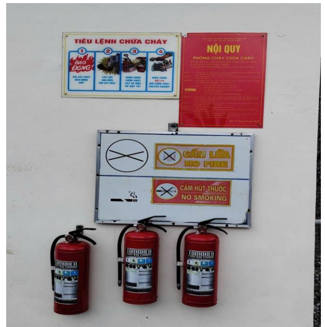
Hình 3.15. Bố trí các thiết bị PCCC tại khu vực kho chứa VLNCN
